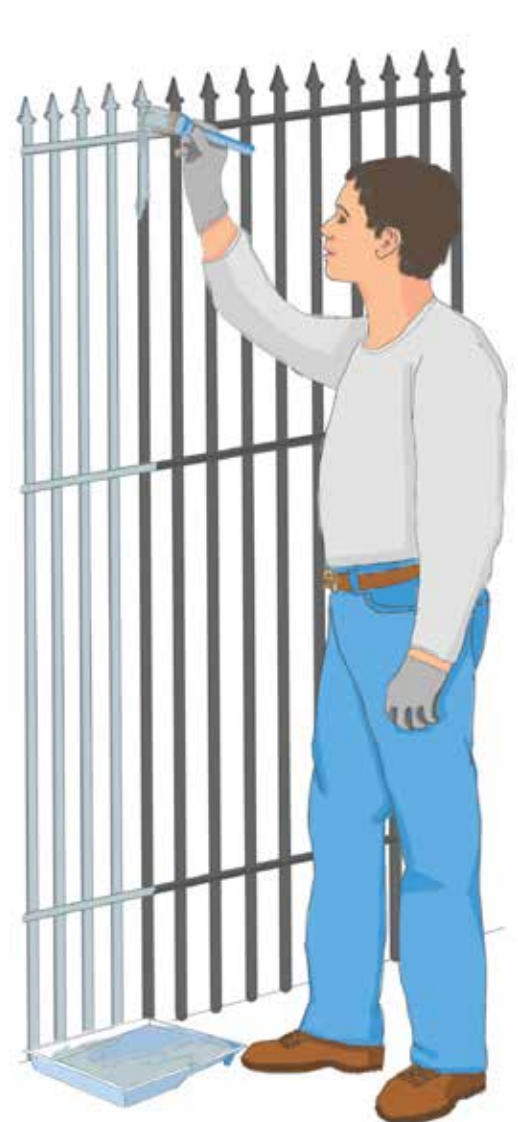
PINTURA DE ELEMENTOS METÁLICOS
