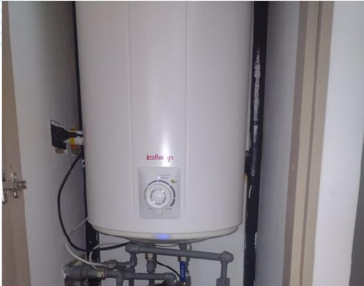
**Termo eléctrico,** encargado de acumular y mantener el agua recibida por el panel solar. Este termo al no tener la necesidad de calentar agua desde la temperatura que entrega la red, funcionará en pequeños ciclos sólo manteniendo la temperatura del agua de consumo.
