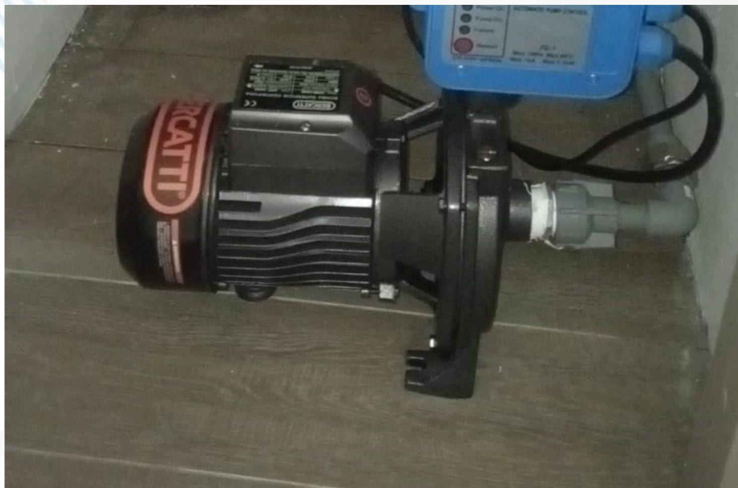
**Bomba de levante,** al recibir la señal del presostato, toma el agua y eleva su presión para que pueda ser usada en el interior del departamento.
