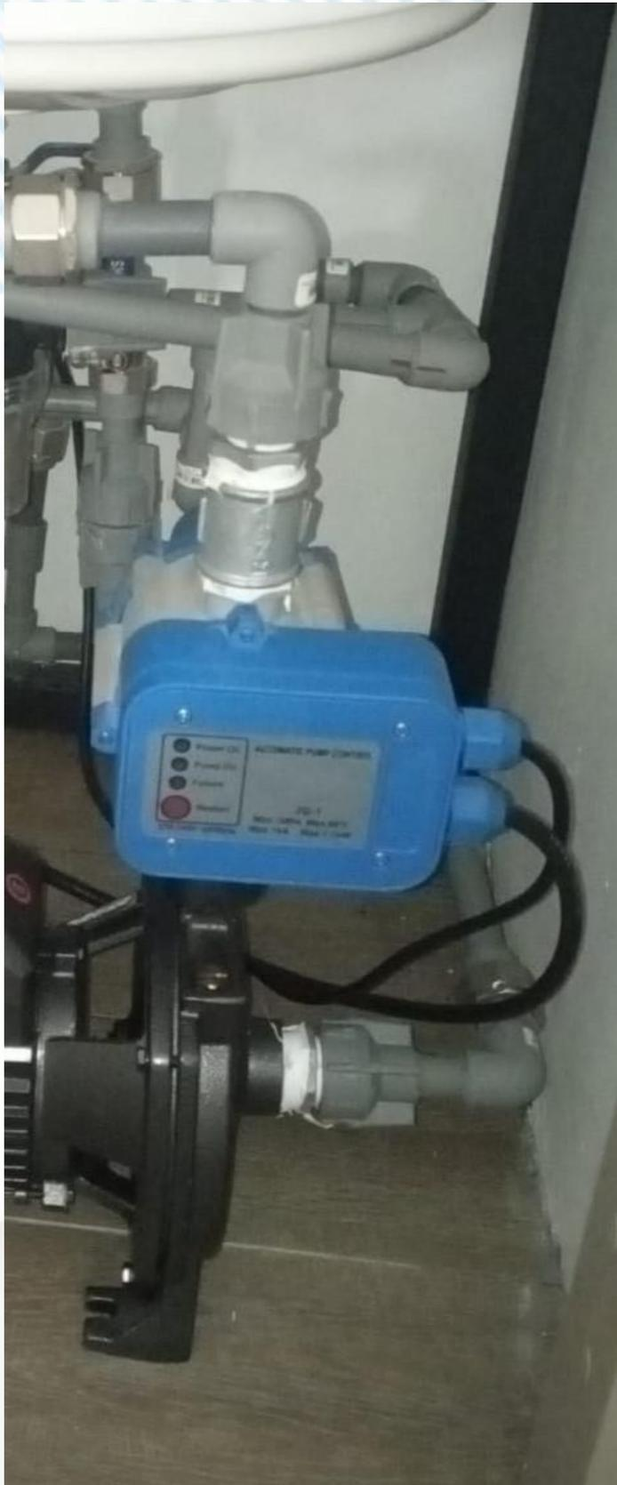
**Presostato**, encargado de darle encendido y apagado a la bomba de levante. Este elemento mide la presión del sistema por lo que con el se puede saber si existe necesidad de presión al abrir una llave en el interior del departamento.
