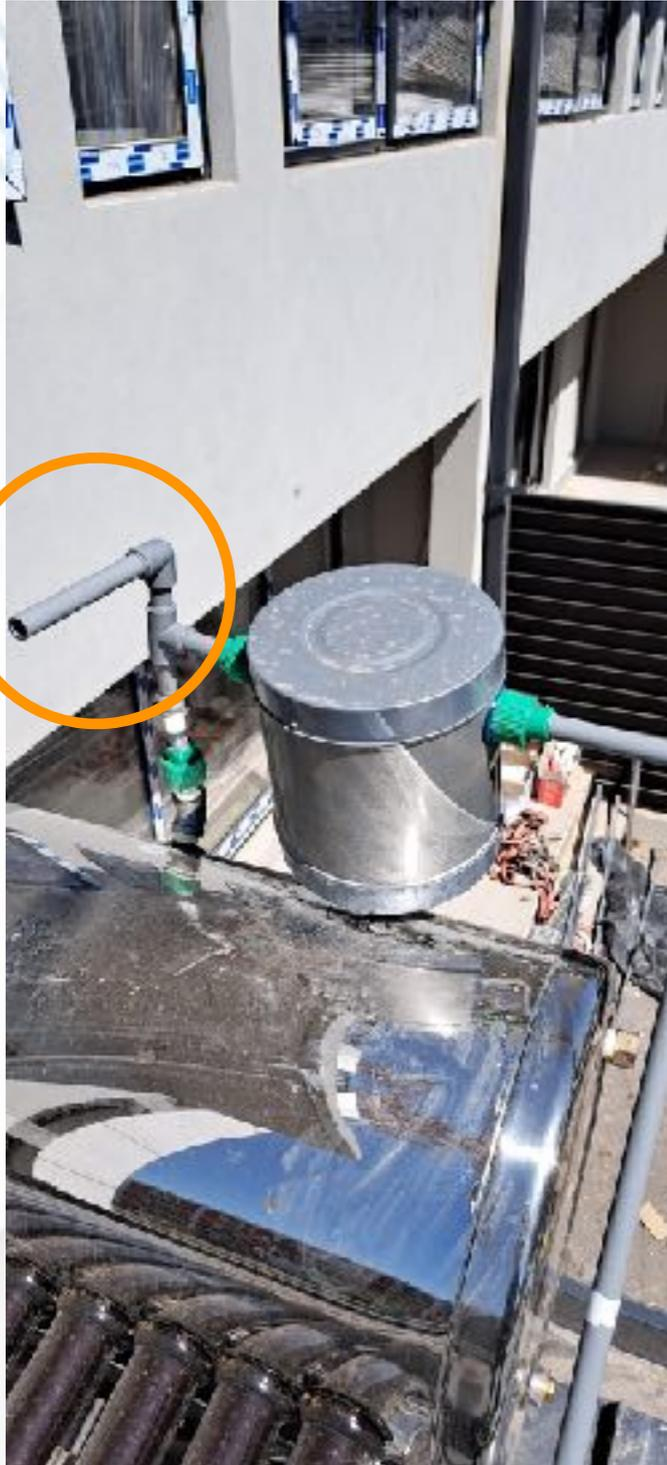
**Venteo,** es una ventilación que evita la sobrepresión en el sistema por el alza de temperatura. Es probable que algunos días de calor en que no se esté ocupando agua caliente en el departamento, por esta ventilación se expulse vapor, ya que el sistema es tan eficiente que puede hervir el agua en su interior. Esto no daña el sistema y no influye en su funcionamiento.
