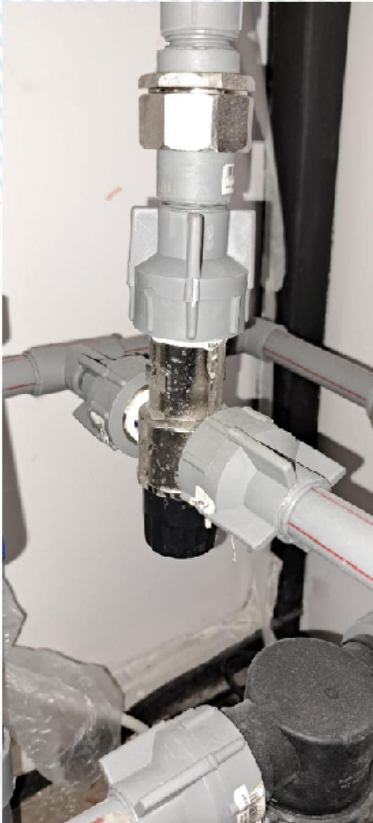
**Válvula mezcladora,** cumple la función de regular la temperatura del agua que ingresa al termo eléctrico proveniente de panel solar. Esta válvula asegura la temperatura adecuada para el usuario.
